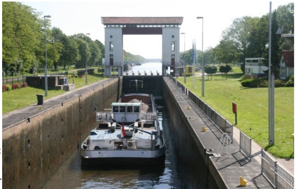
Een geladen schip in de sluisolk, langzaam rijzend naar kanaalhoogte.
