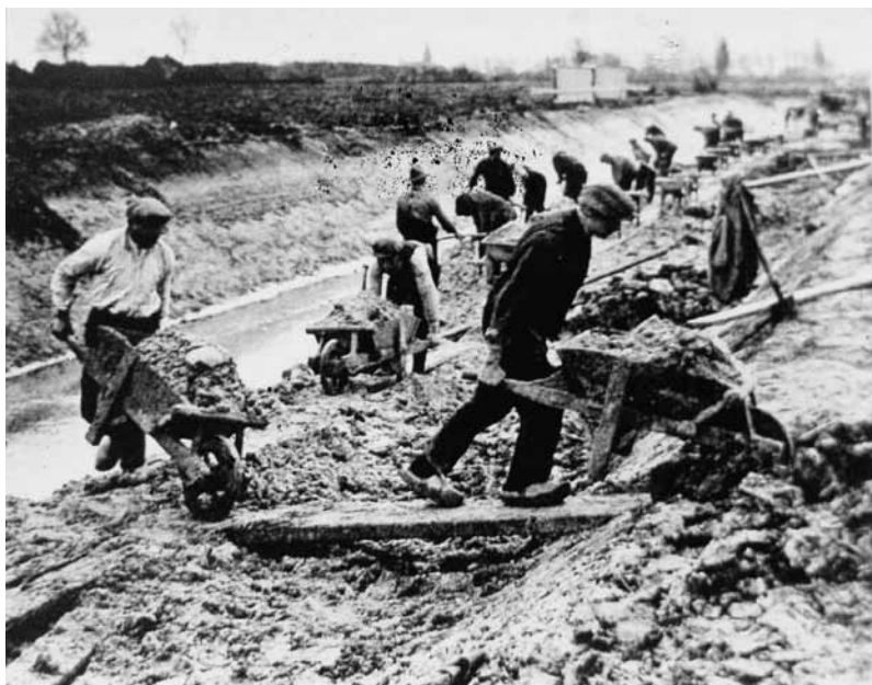
Werkverschaffing, 1933, het graven van het Twentekanaal; alles gebeurde met handkracht.
