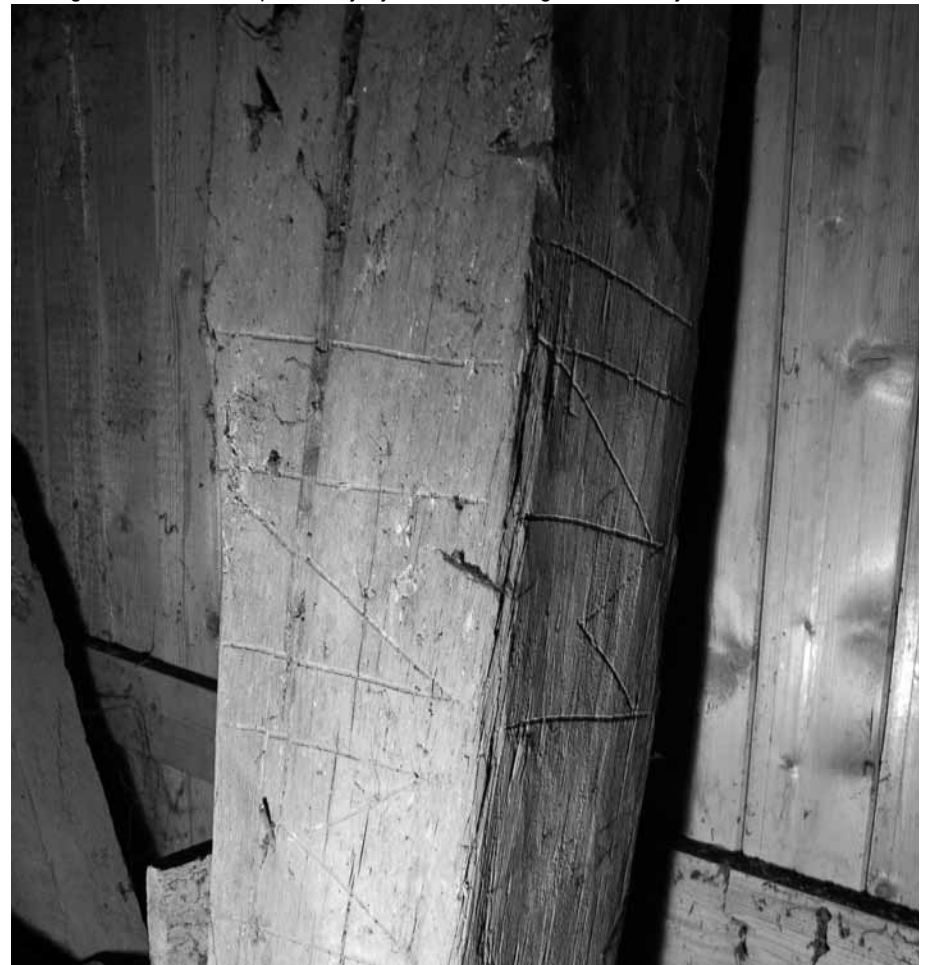
Detail gebintconstructie. Op deze stijl zijn telmerken aangebracht, foto juni 2004
