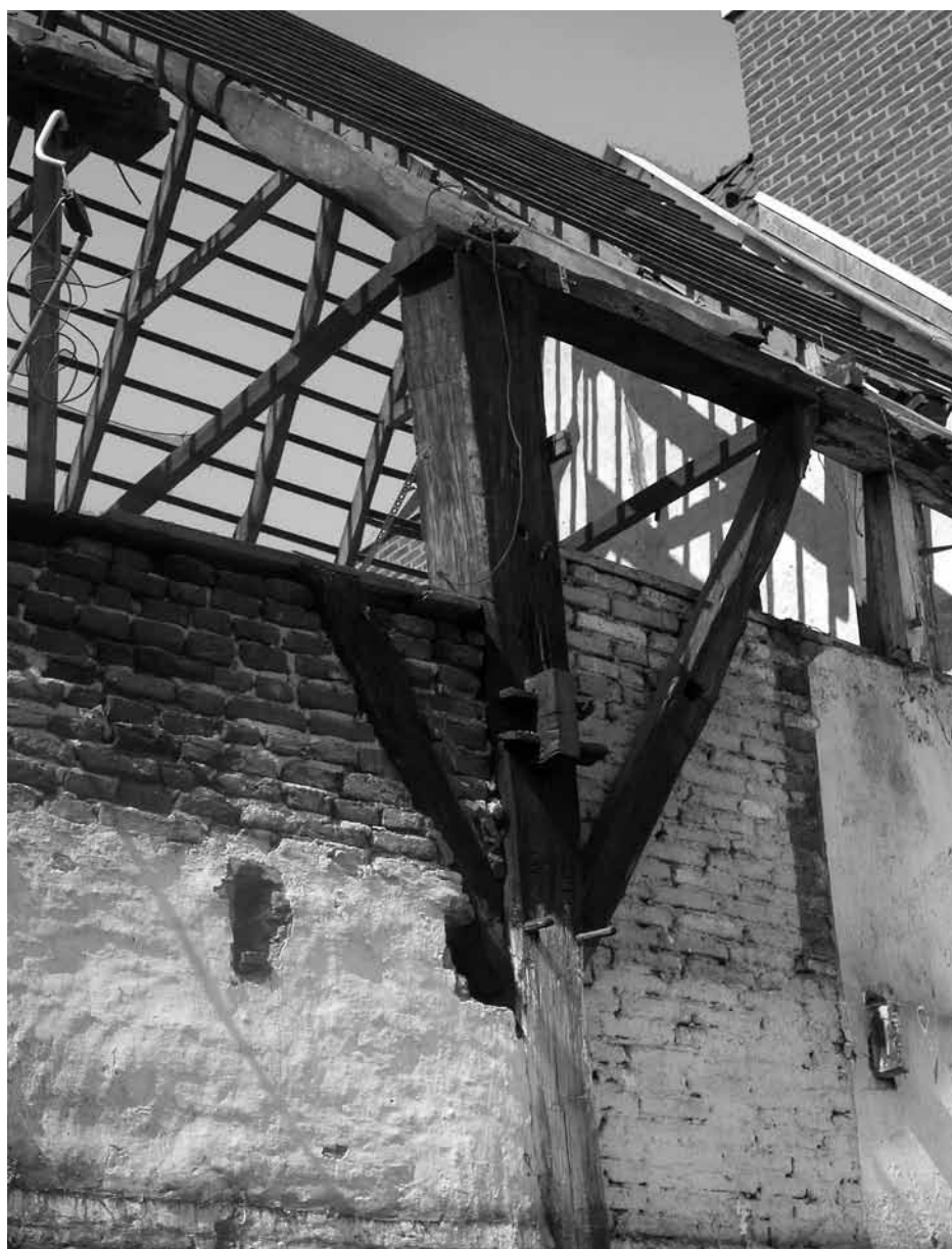
Detail gebintconstructie in achtergevel, april 2005
