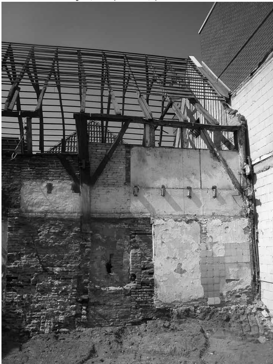
Detail achtergevel, na sloop achterhuis, april 2005
