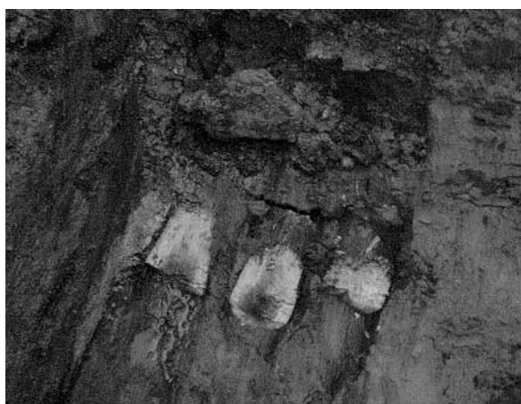
Onderkant stadsmuur. Onder het metselwerk liggen de boomstammetjes.
