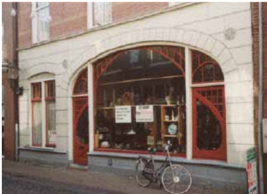
Jugendstilpui van Walderstraat 17. Kenmerkend zijn de sierlijk gebogen roeden en de glas-in-loodramen in de bovenlichten
