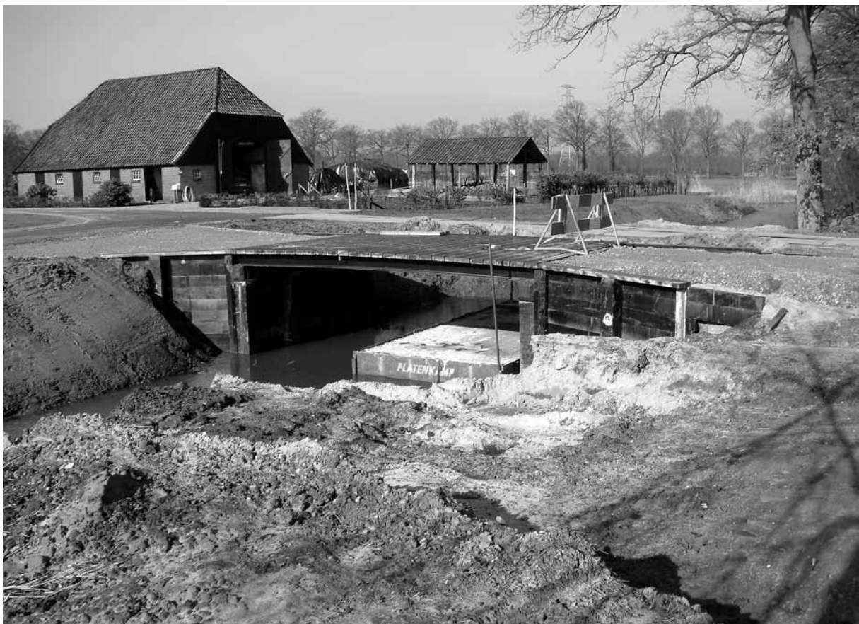
De houten brug over de buitengracht in de afrondende fase.
