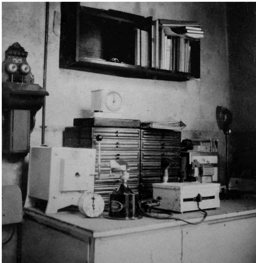
Interieur van het laboratorium aan de Zuiderwal, 1938. Links staat een verhitingsoven, daarnaast een slingerapparaat, een lasapparaat en een porseleinoven. Daarachter staan tandenkastjes.
