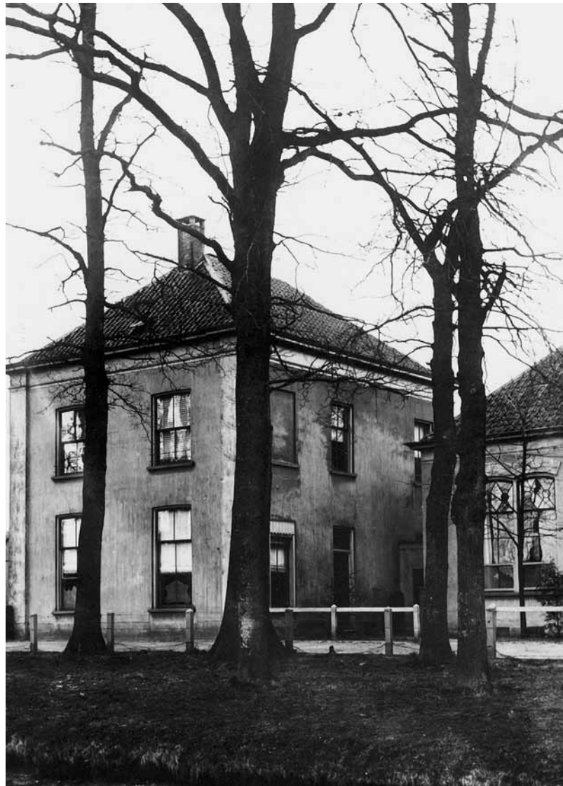
In het meestershuis van School I (Zuiderwal) was het laboratorium van Smithuis jarenlang gevestigd. Deze foto dateert uit omstreeks 1940.
