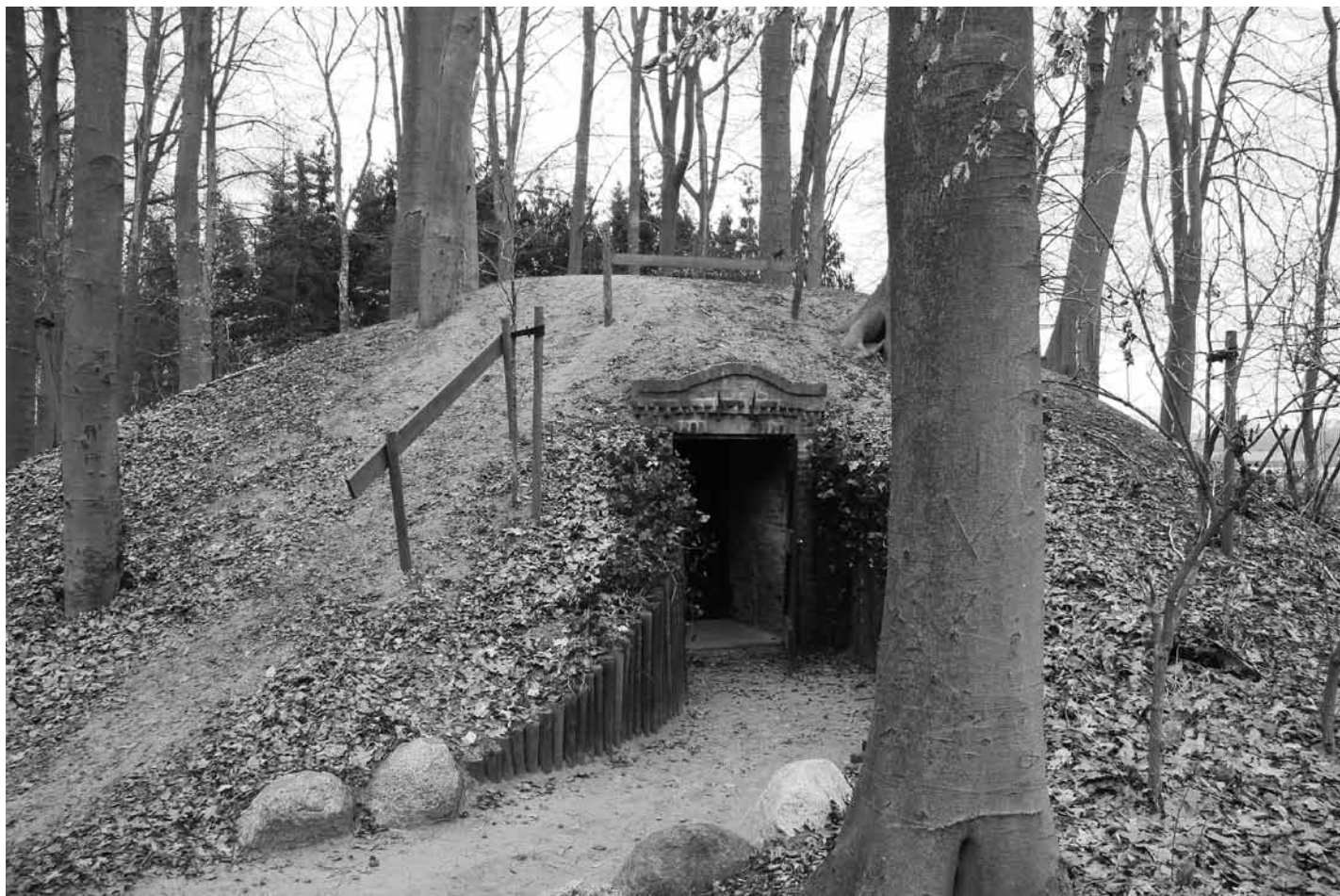
Ijskelder in het Rossbos bij Groot Dochteren. Achter de openstaande eerste deur bevindt zich nog een extra deur voor de isolatie van de kelder (foto Loek Kemming)
