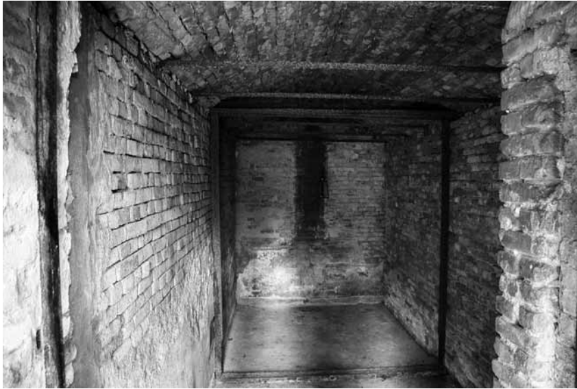
Het interieur van de ijskelder van 't Ross; een eenvoudig rechthoekig vertrek verstevigd met ijzeren balken (foto Loek Kemming)
