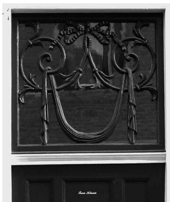
bovenlicht Blauwe Torenstraat 7, Lochem, foto auteur, 2007
