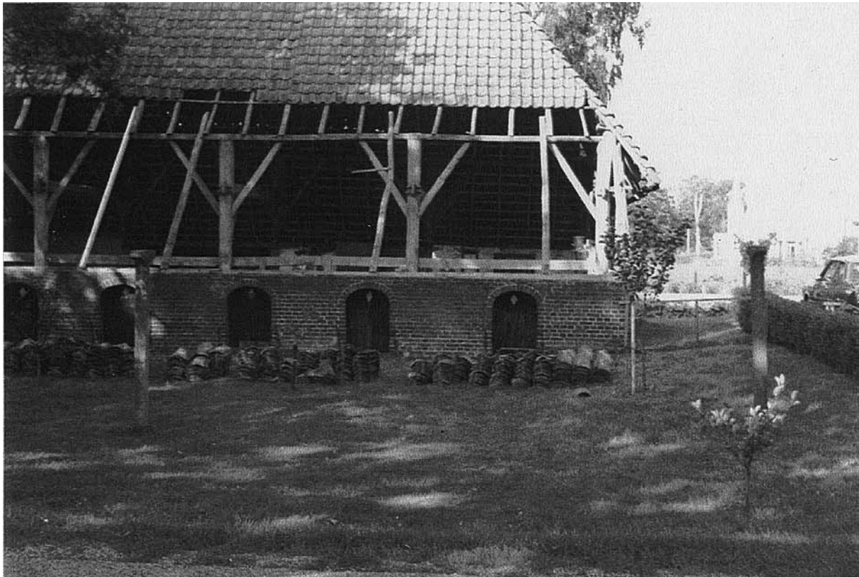
Verbouw schuur rond 1980, collectie Gerrie Schot, Lochem
