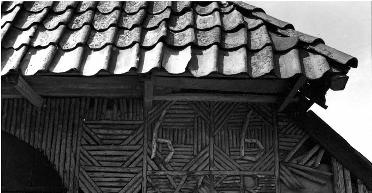
Wandtechniek straatgevel Klein Burink, Zwiepseweg 164, 2 cijfers van het jaartal 1866 in houtmozaïek, 18 ter linkerzijde van de toegangsdeuren. Foto: Historisch Genootschap, situatie in 1976
