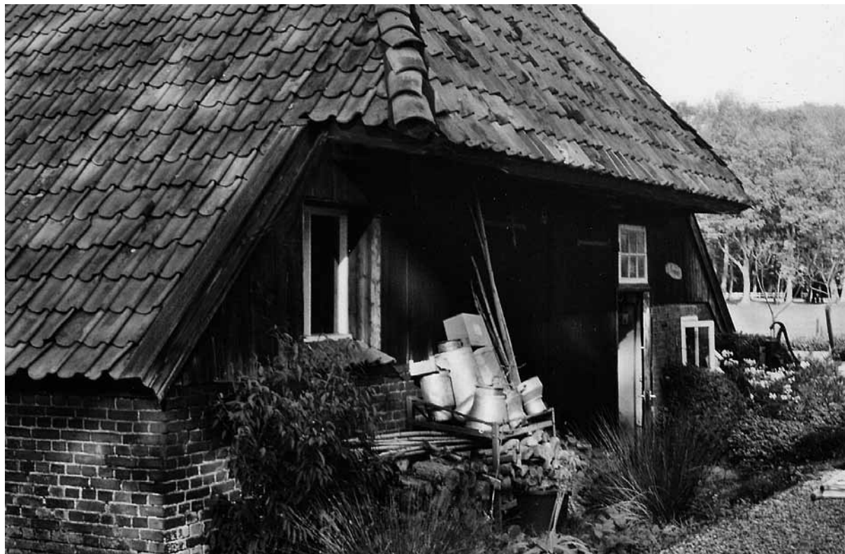
Voorgevel schuur, Langen, rond 1860, foto: auteur. 2011
