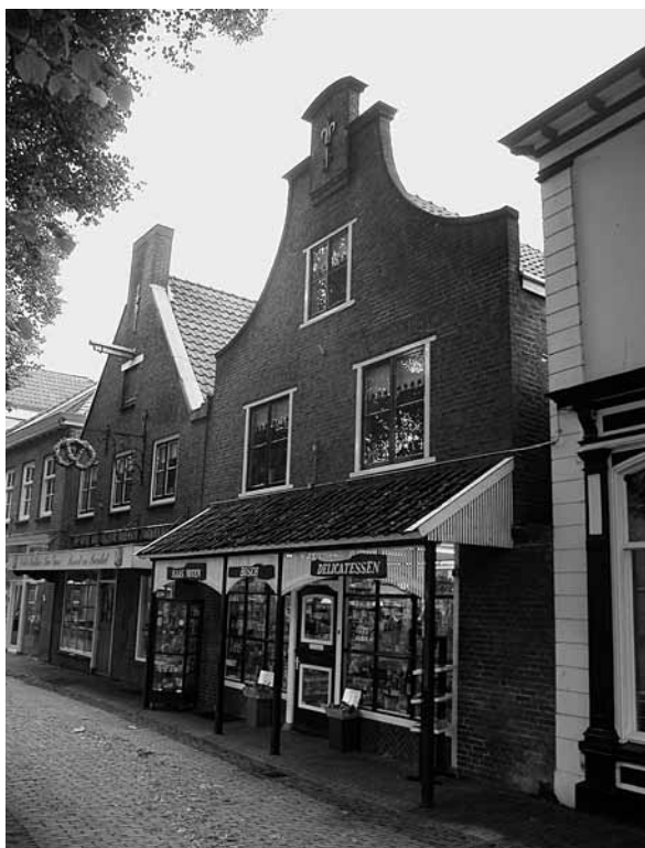
Twee winkelpanden in Delftse Schoolstijl aan de Bierstraat in Lochem (1949-1950, architect G.K. Veeze)
