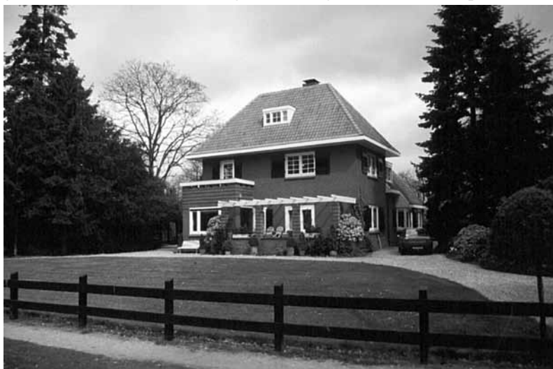
Villa aan de Marinus Naefflaan 42 in Lochem (1924, architect G.J. Postel)
