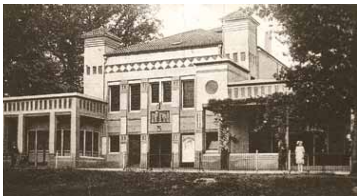
De schouwburg aan de Oosterwal. Aan de rechterzijde van het gebouw bevond zich de lokaliteit van sociëteit De Harmonie, ca 1915 (Archief Historisch Genootschap Lochem-Laren-Barchem)
