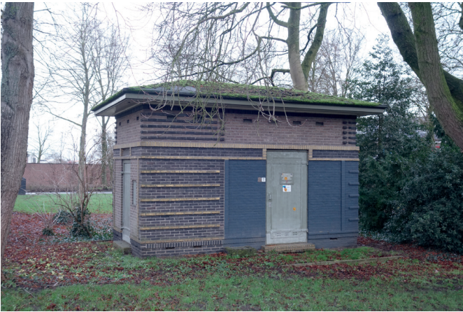
Het transformatorhuisje aan de Prins Bernhardweg in Lochem. De grijze verlaag op het rechter gedeelte is niet origineel.
